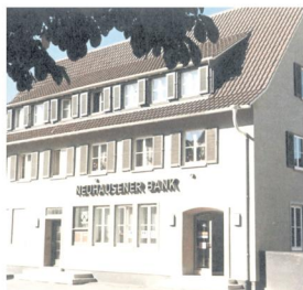
Das Bankgebäude der Neuhausener Bank im Jahr 1938.
